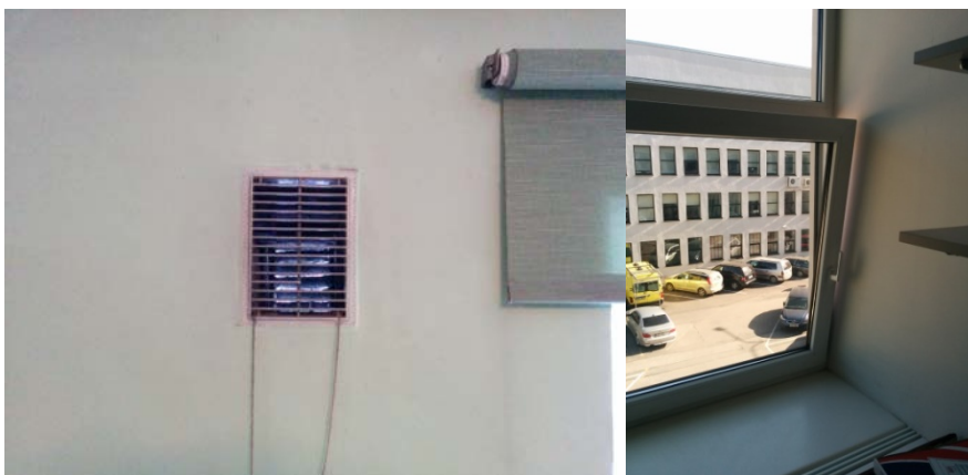
Joonis 6.3. Loomulik ventilatsioon läbi restide või akende avamise abil, mis tagab ainult IV sisekliimaklassi nõuded.
