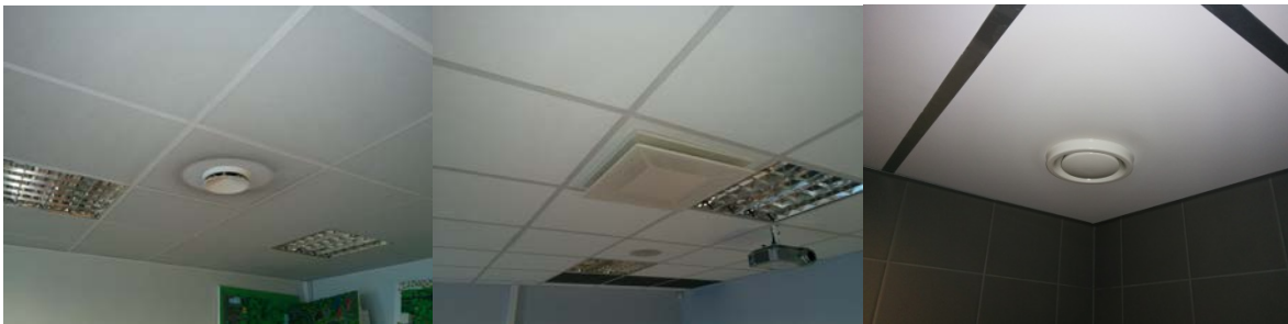
Joonis 6.5. Mehaanilise ventilatsiooni lõppelemendid, kaks vasakpoolset on sissepuhkeks ja parempoolne väljatõmbeks. On loodud eeldused I või II sisekliimaklassi saavutamiseks.
