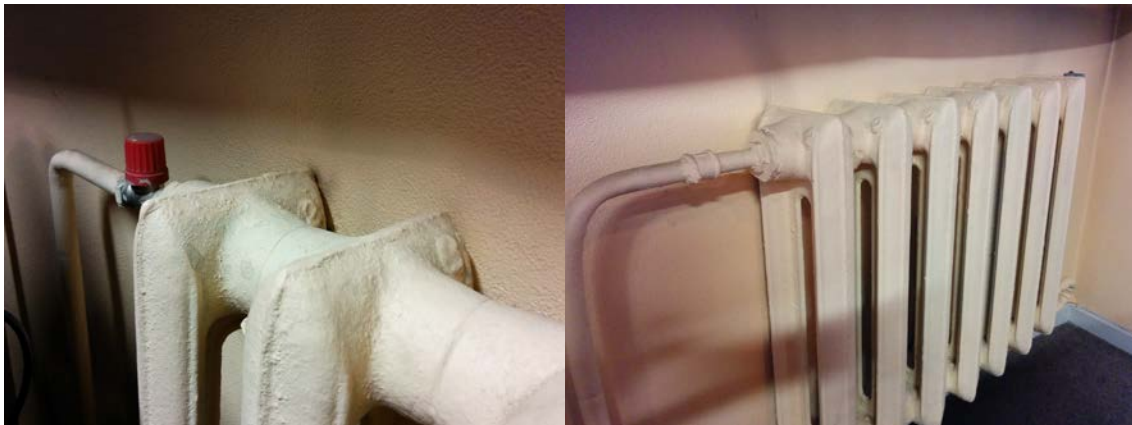
Joonis 6.1. Radiaatorid, millel puudub ruumipõhine temperatuuri reguleerimise võimalus. Vasakpoolse radiaatori ühendustorul on seadeventiil, aga see ei reguleeri radiaatori soojusväljastust vastavalt ruumitemperatuurile. Saavutatav sisekliimaklass on IV.
