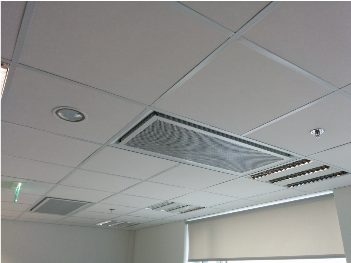
Joonis B.2. Ruumide sissepuhkeks ja jahutamiseks kasutatakse aktiivjahutustalasisid.
