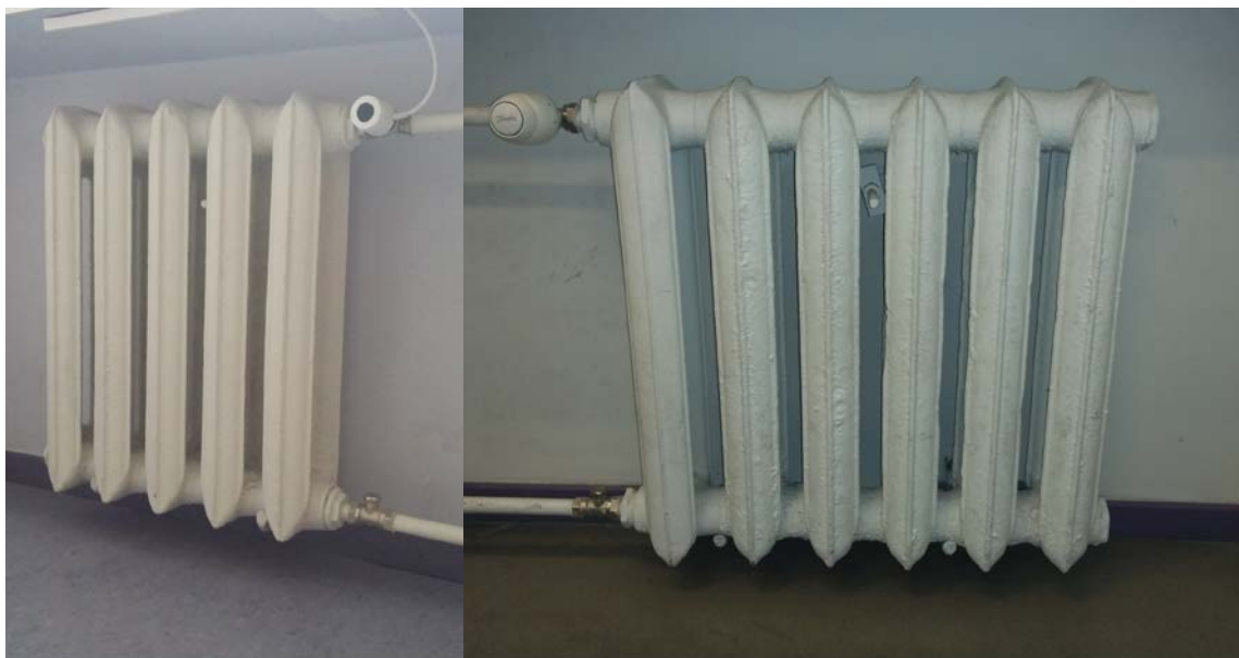
Joonis A.1. Jahutusega ruumides on radiaatoritel termoajamiga ventiilid (vasakul) ja ülejäänud ruumides omajõulised termostaatventiilid (paremal).
