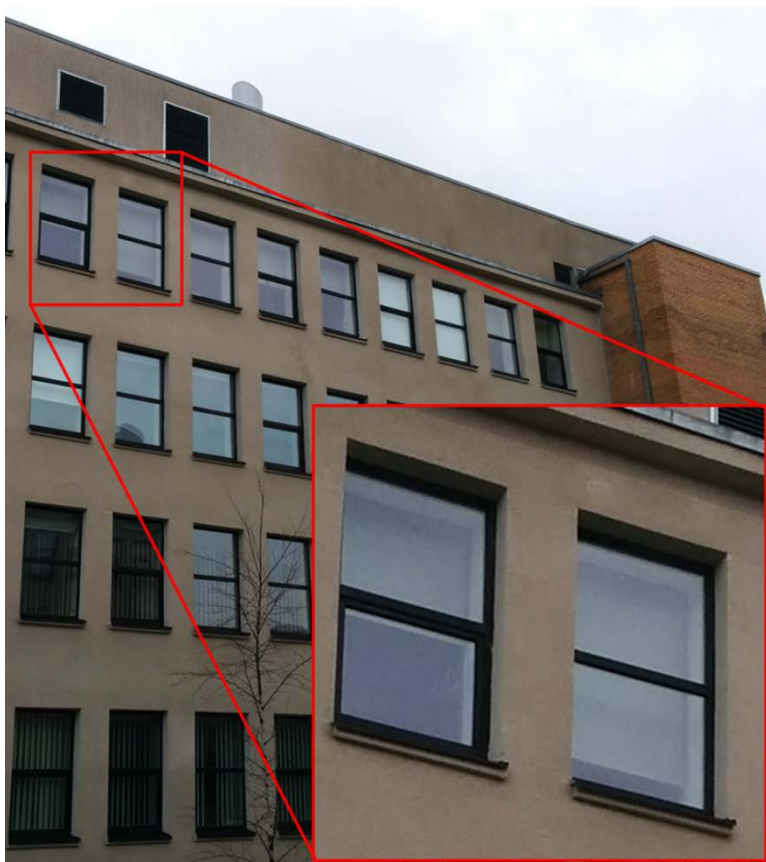
Joonis A.10. Õppehoone läänefassaad, detailselt on näidatud „Kabinet W“ aknaid, millest ainult vasakpoolse alumine osa on avatav. Kui aken on tuulutusasendis, siis avatud osa ülemine äär 150 mm kaugusel aknast ja vastavalt toodud arvutusele on avatud osa pindala 6,6% kogu akna pindalast.
